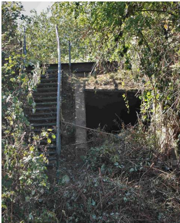
Freischneiden des Stollens
