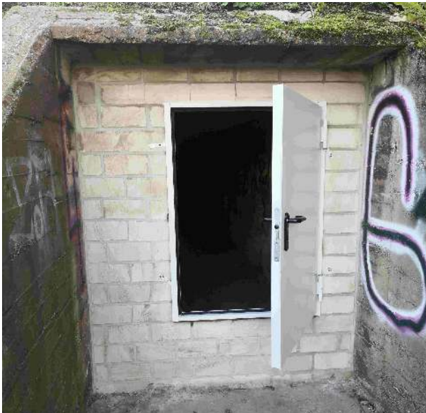
Neuer Zugang zum Stollen
